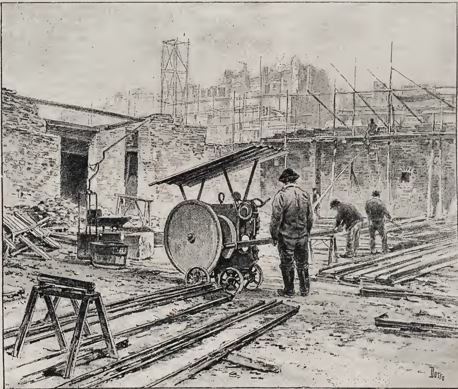
LES TRAVAILLEURS DE L'EXPOSITION. — Une poinçonneuse et son équipe de serruriers.
